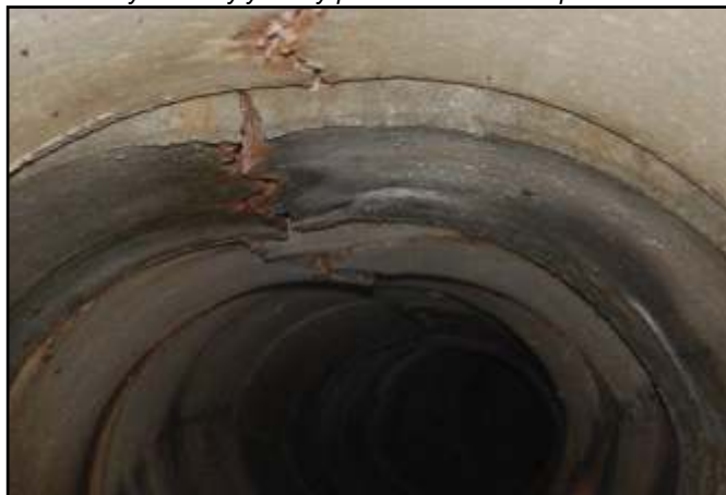
Toto je dnešní stav potrubí, které bylo při budování rybníka v 70. letech zcela nevhodně použito - má ještě někdo názor, že současný stav rybníka je vina dnešního zastupitelstva?
